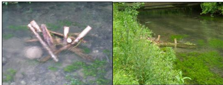
Figure 60 : aménagements réalisés par l'Association Syndicale de la Selle et permettant de restaurer des habitats piscicoles
